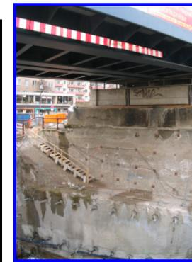
Bild 5, Blick von der überdeckelten Baugrube gegen die durch eine Bodenvernagelung und durch Schlitzwände gesicherte Baugrube unter der DB-Brücke
