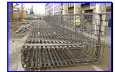
Bild 7, Bewehrungskorb zur Bewehrung einer Schlitzwandlamelle
