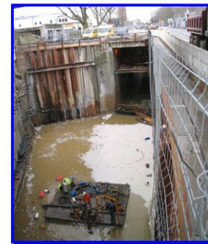
Bild 4, temporärer Abschluss des Streckenabzweiges durch eine Spundwand und weitere überdeckelte Streckenführung in Richtung Großmarkt
